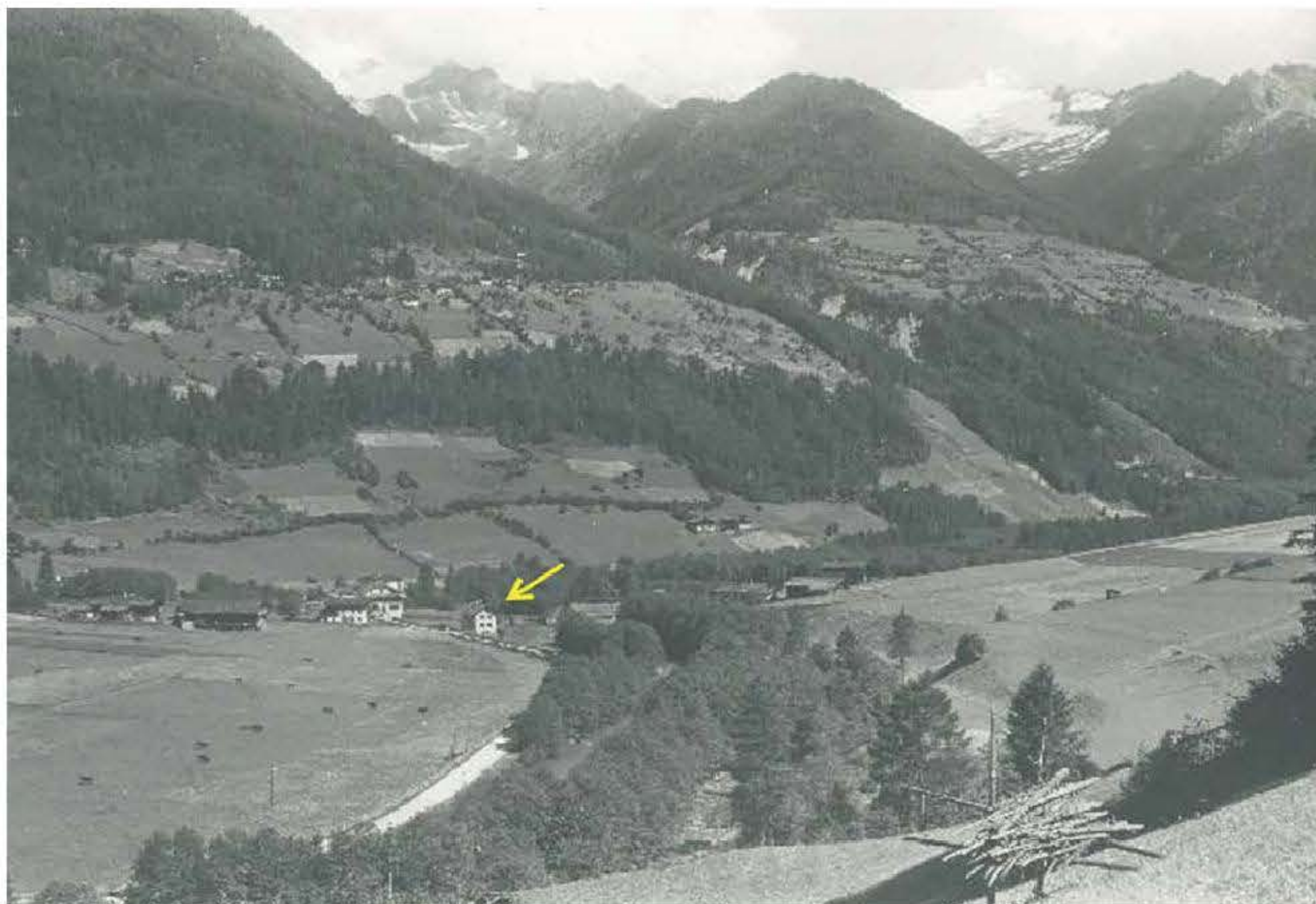
Die ehemalige Gipshütte im Mairboden. Später Wohnhaus, Postamt und „Dopolavoro“, dann Hotel Post, jetzt Pension Olympia. Fotosammlung Franz Innerbichler (um 1940)
