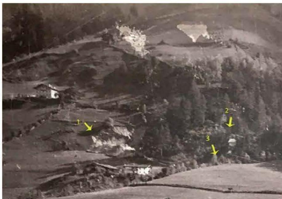
1 Der Steinbruch, 2 Die Brechmaschine, 3 Standort der Gipsmühle. Das Foto stammt aus dem Jahr 1911 und zeigt das Lembachanwesen und ein Stück des Gipsweges (unten) und Umgebung: offensichtlich stand die Gipsmühle damals noch nicht. Foto Hermann Oberhofer
